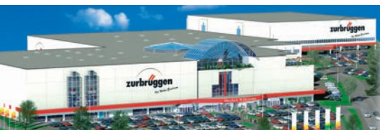
Wohnzentrum Zurbrüggen in Unna
